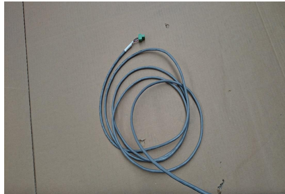
Fot 28. Kabel zasilania panelu sterującego na drzwiach. Należy przeprowadzić do otworu w drzwiach przez tuleje na prawym górnym rogu drzwi (fot nr 36)
