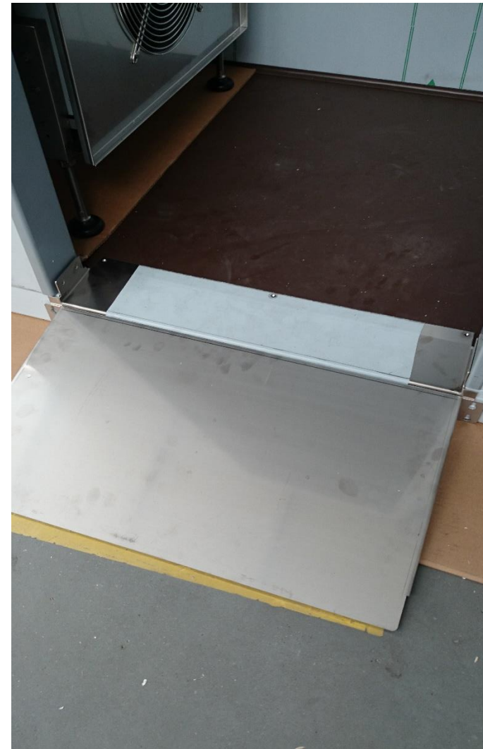
Fot 20. Listwa progowa i rampa wjazdowa przykrecone blachowkretami.
