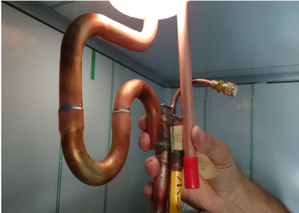
Fot 25. Polaczenie zaworu rozprężnego z parownikiem (po wylutowaniu zaślepek)
