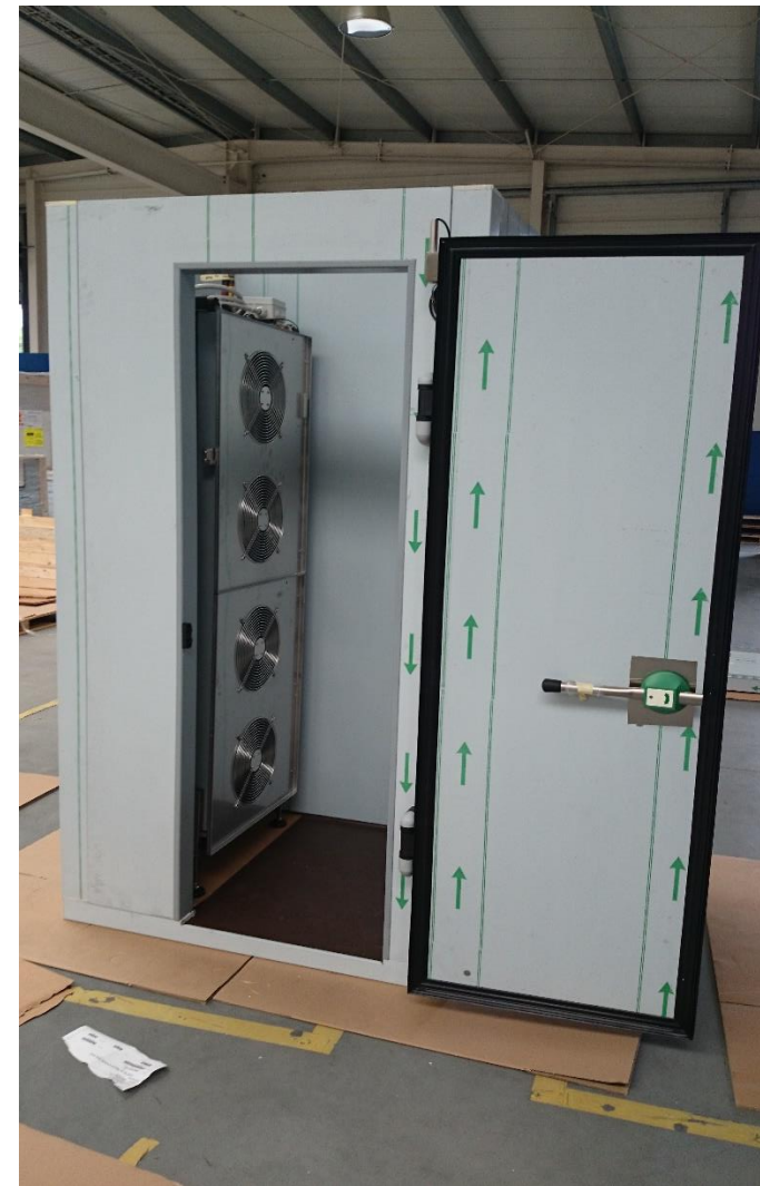
Fot 18. Zamontowana ściana frontowa z drzwiami.
