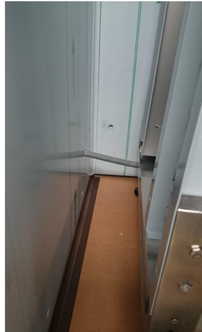
Fot 16. Wstawienie parownika – wyprowadzenie odpływu kondensatu przez otwor w lewej scianie bocznej.
