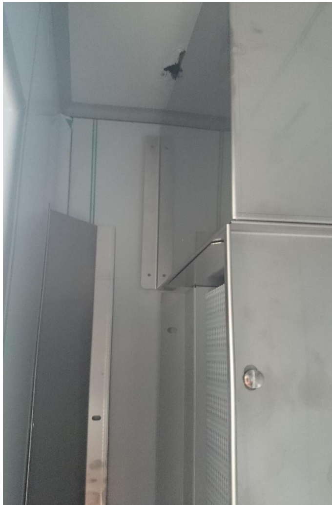
Fot 19. Listwy w narożnikach korpusu za parownikiem (przykrecic do scian blachowkretami).
