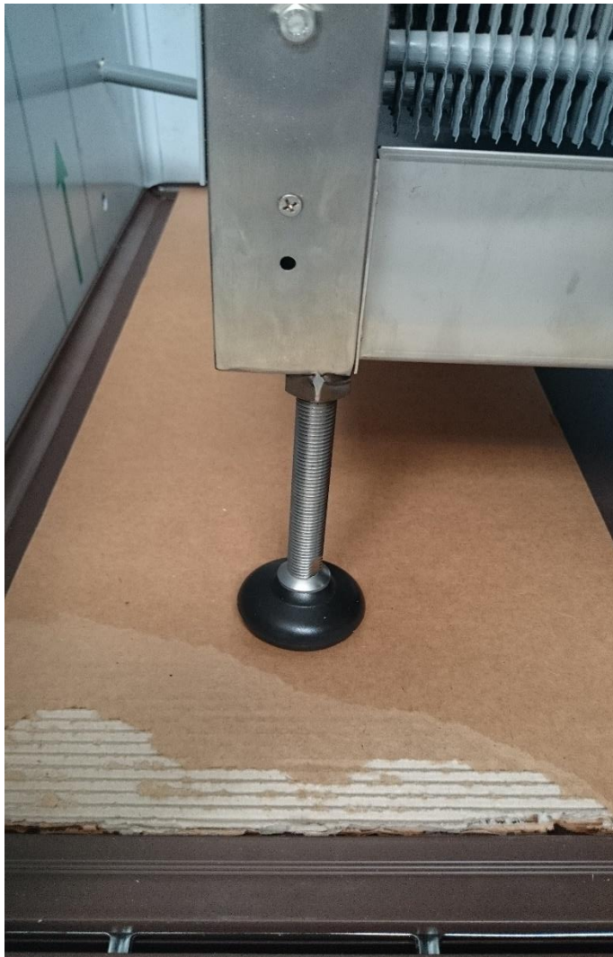
Fot 17. Regulacja wysokości parownika (rurka odpływu kondensatu musi mieć spadek).
