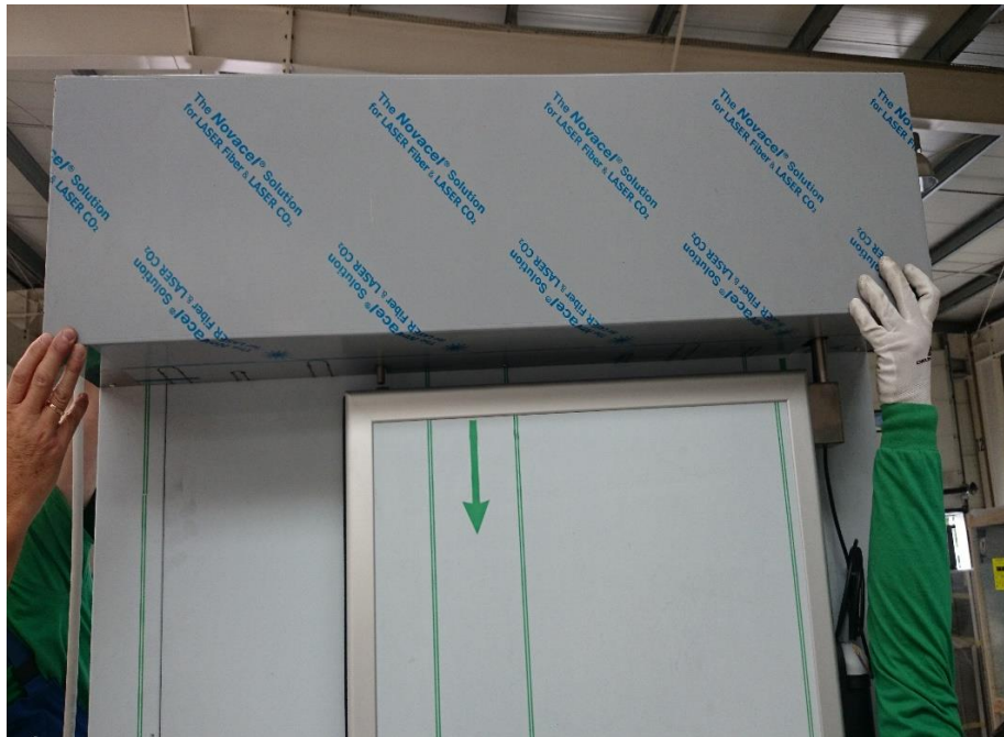
Fot 21. Panel zasilania nad drzwiami (przymocowany do korpusu blachowkrętami).
