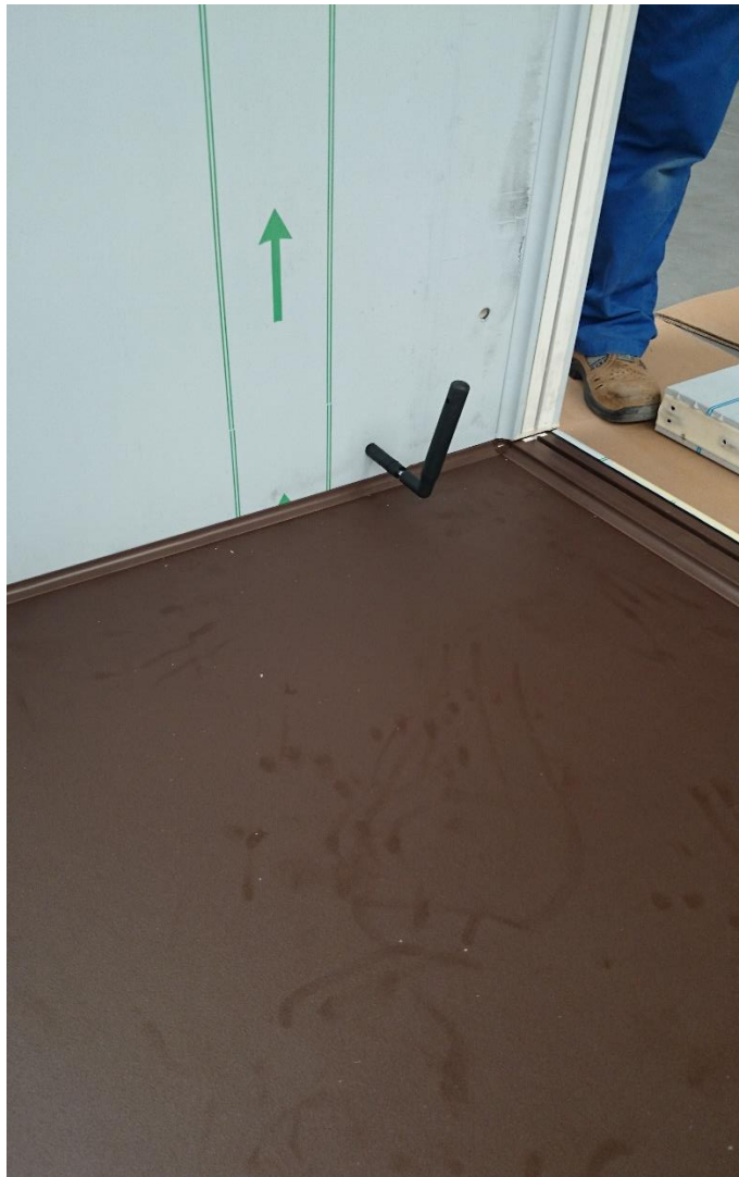
Fot 13. Czesci korpusu – montaż scian do podlogi kluczem szesciokatnym.
